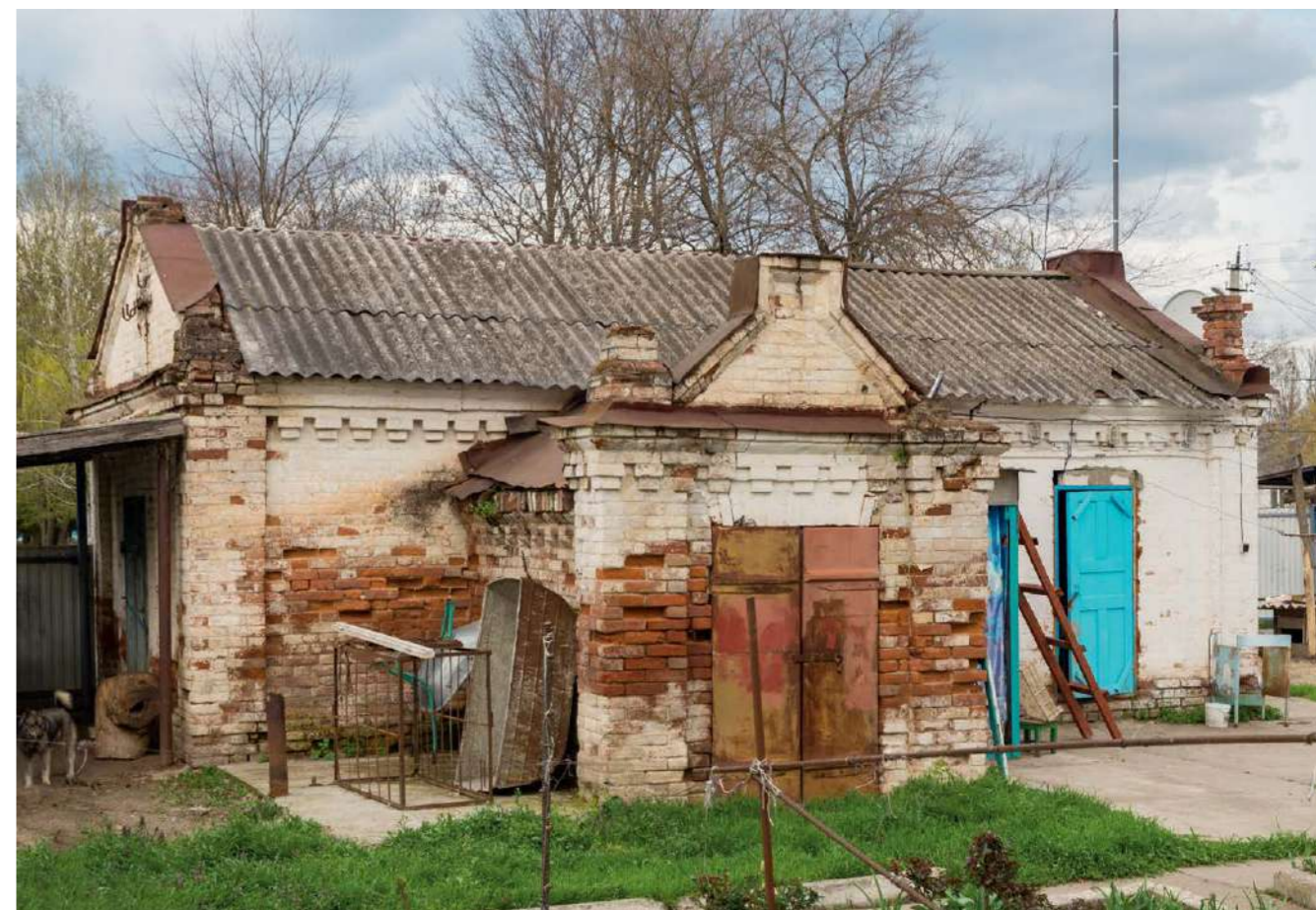
Хозяйственная постройка с подвалом в усадьбе Н. И. Озерова (ныне – жилой дом), пос. Ботаника
