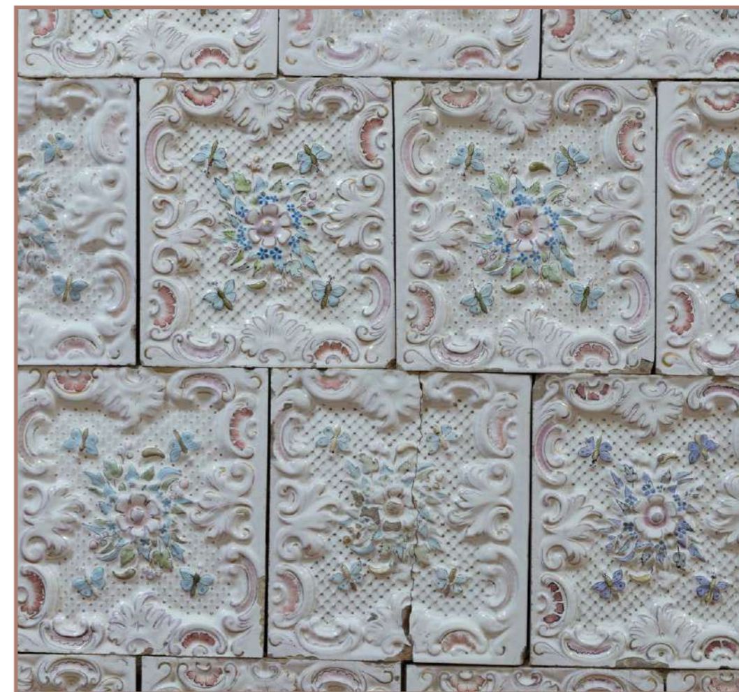
Фрагмент облицовки лицевого зеркала
